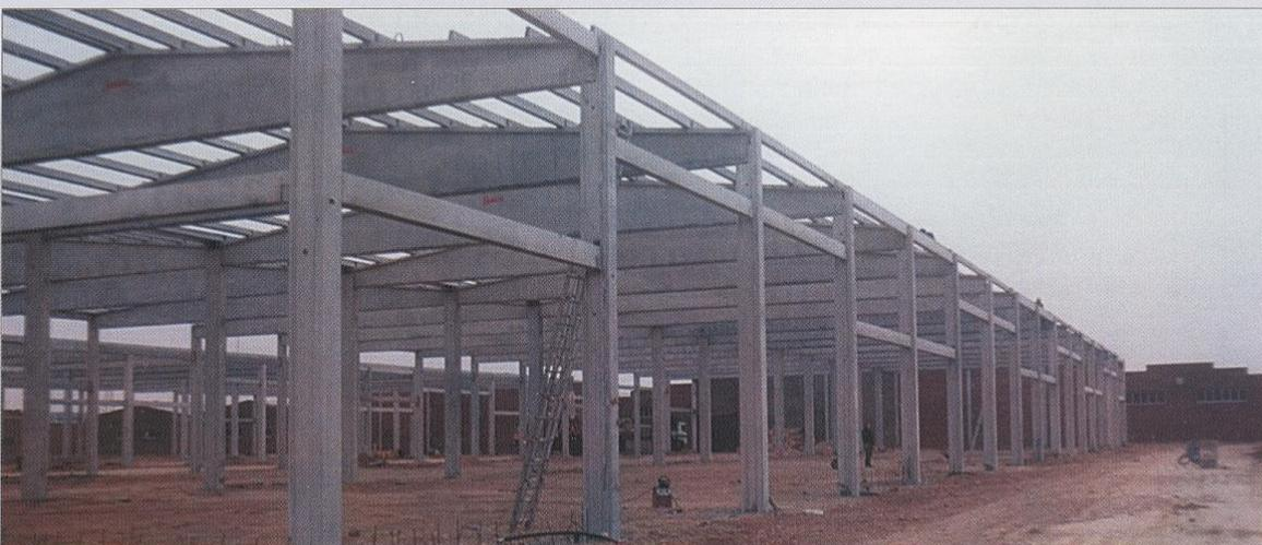
Arriostamiento lateral de la estructura: Vigas de atado para sujeción de fachada.
