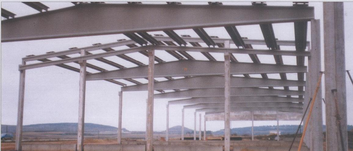
Fácil montaje de la estructura: Pilares, Vigas y Correas.
