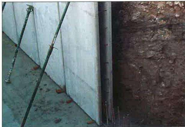
Apuntalado y nivelado del muro MPR.
